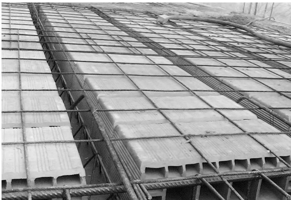
Figura 3.1. Assemblaggio in opera di solaio in laterocemento
