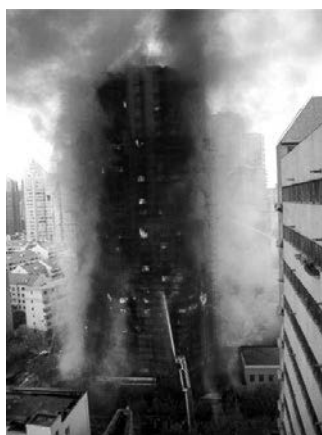
Figura 1.1. Edificio di grande altezza interessato da incendio.
