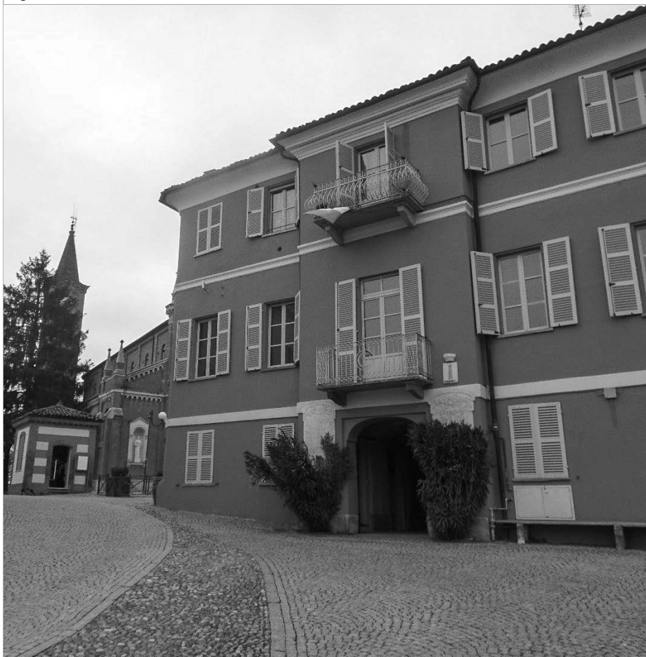
Figura 10.2. Facciata principale edificio oggetto di intervento
