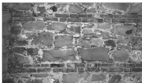
Presenza di ricorsi continui e discontinui in mattoni pieni, in presenza di pietrame discretamente squadrato
