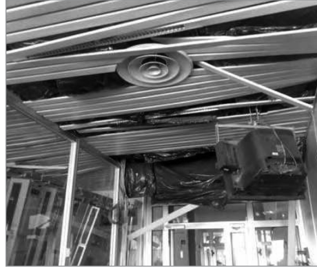
Figura 13.2. Danni causati dal crollo di controsoffitture
