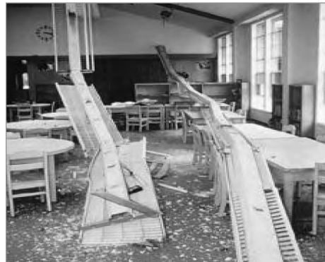
Figura 13.3. Danni causati dal crollo di sistemi di illuminazione
