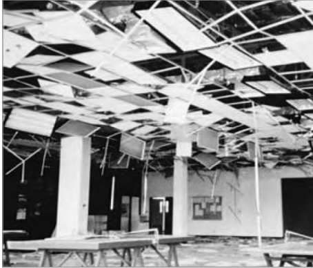
Figura 13.2. Danni causati dal crollo di controsoffitture
