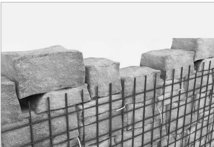
Figura 7.1. Sistemi FRCM in fibra di vetro
