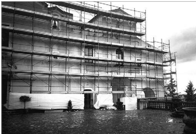
Figura 6.1. Miglioramento sismico di una struttura in muratura
