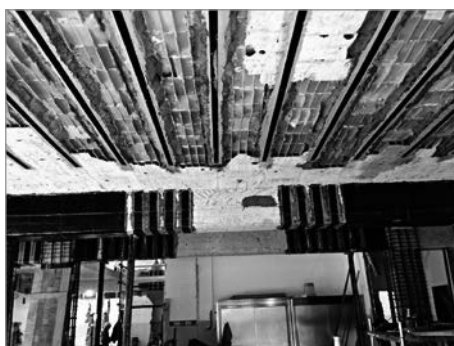
Figura 12.3. Consolidamento di solai e travi in c.a. con CFRP
