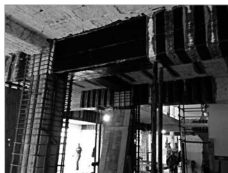
Figura 12.3. Consolidamento di solai e travi in c.a. con CFRP
