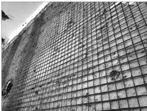
Figura 9.2. Rinforzo muratura con CRM
