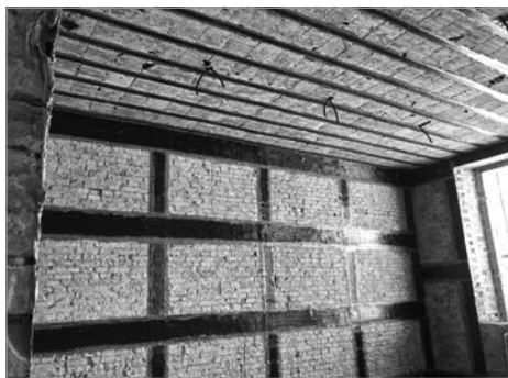
Figura 12.2. Consolidamento di murature con CFRP
