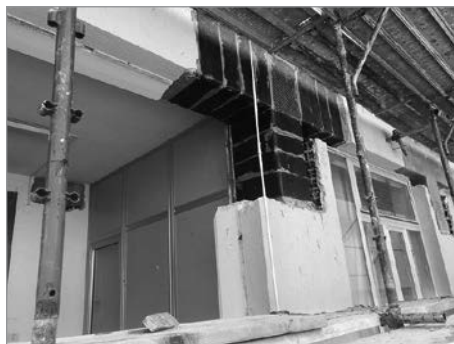
Figura 12.1. Consolidamento di nodi perimetrali con CFRP
