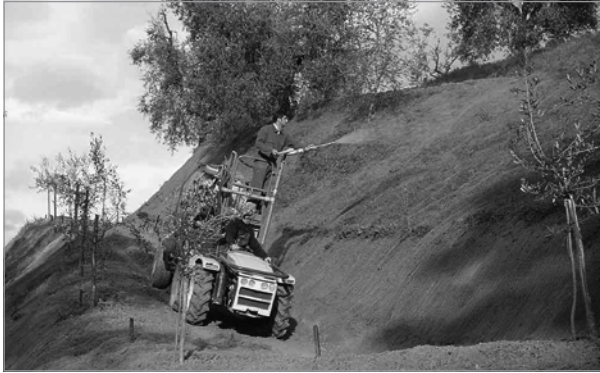
Figura 2.1-1. Idrosemina con trattrice (da ingiardinoweb.it, per gentile concessione)
