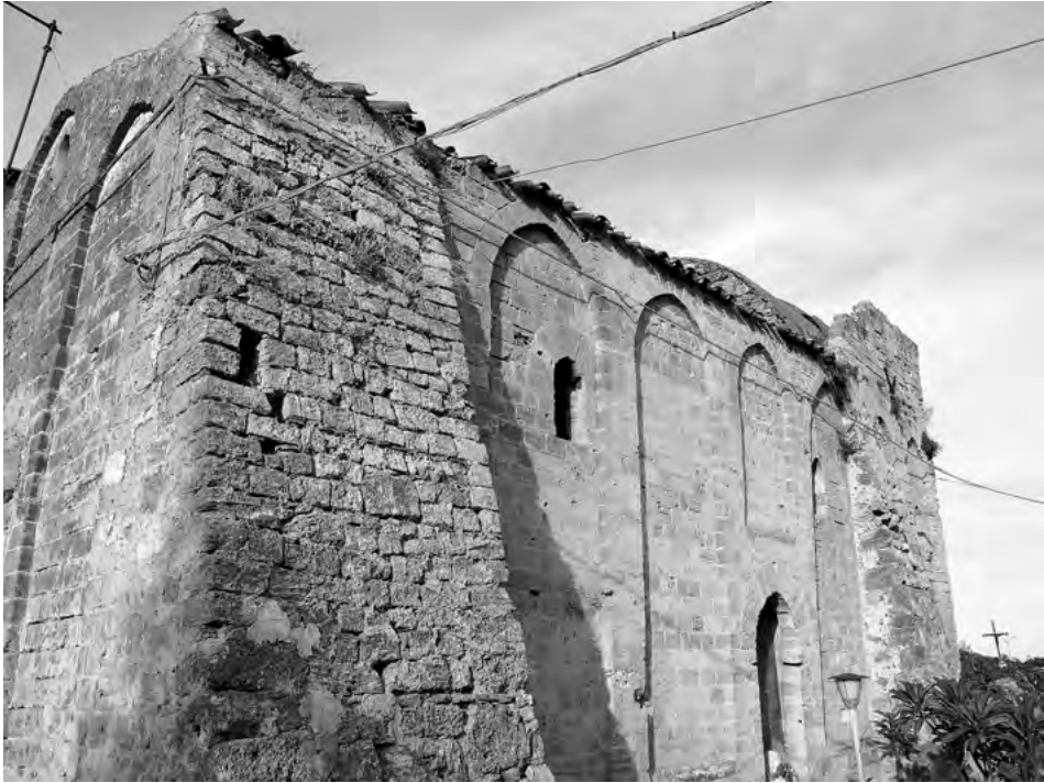
Figura 8. Speroni addossati per evitare il ribaltamento, durante i restauri di inizio secolo di Francesco Valenti alla chiesa normanna dell'Uscibene a Palermo.
