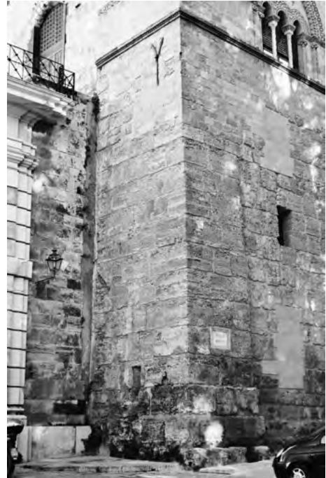
Figura 5 (sinistra). Parete di rafforzamento strutturale intorno all'arco, che oblitera anche le paraste laterali nel Palazzo Forcella-De Seta a Palermo.
