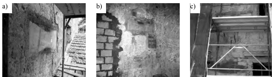
Figura 2.12. a) riconnessione con connettori di pietrame nella parete esterna; b) eguale intervento nella parete interna; c) tubicini in PVC entro cui si inietta la malta di calce.
