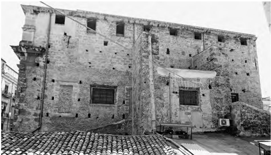
Figura 7. Contrafforti posti in opera nella chiesa dei SS. Quaranta Martiri alla Guilla a Palermo dopo il sisma del 1726.
