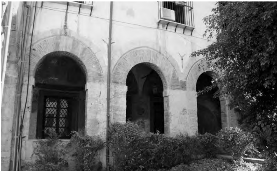
Figura 9. Sottoarchi e rinforzo dei pilastri in mattoni apposti per sopportare il carico soprastante dopo il sisma del 1823 a Palermo nel Convento di S. Francesco d'Assisi.
