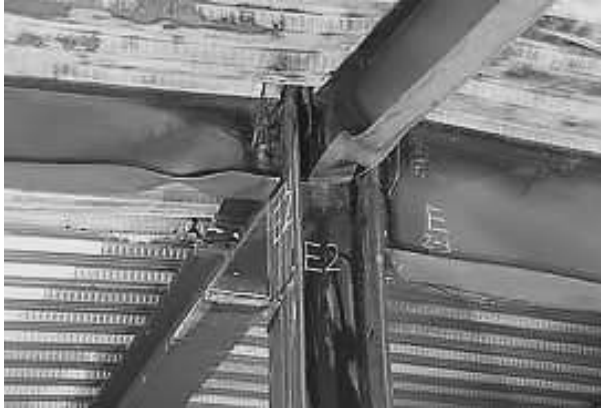
Figura 2.18. Instabilità in compressione
