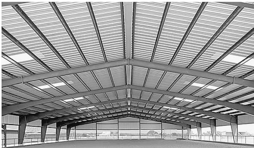
Figura 2.12. Travi principali e arcarecci
