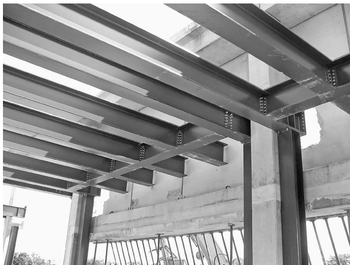
Figura 2.16. Trasmissione indiretta del carico
