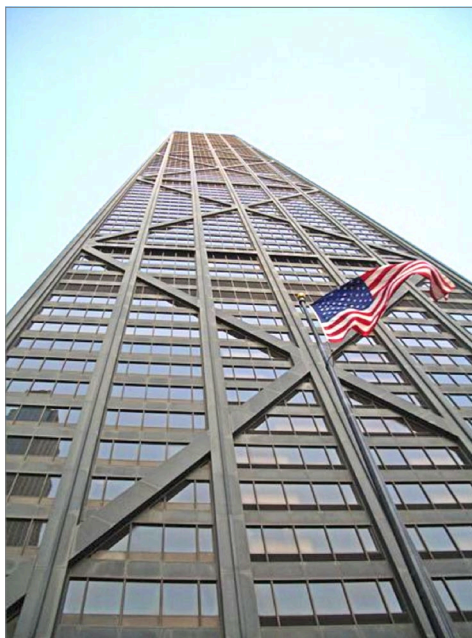
Figura 1.2. Controventi valorizzati come motivo estetico nella John Hancock Tower di Chicago (da Wikipedia, foto di “Akavid”, 2008)
