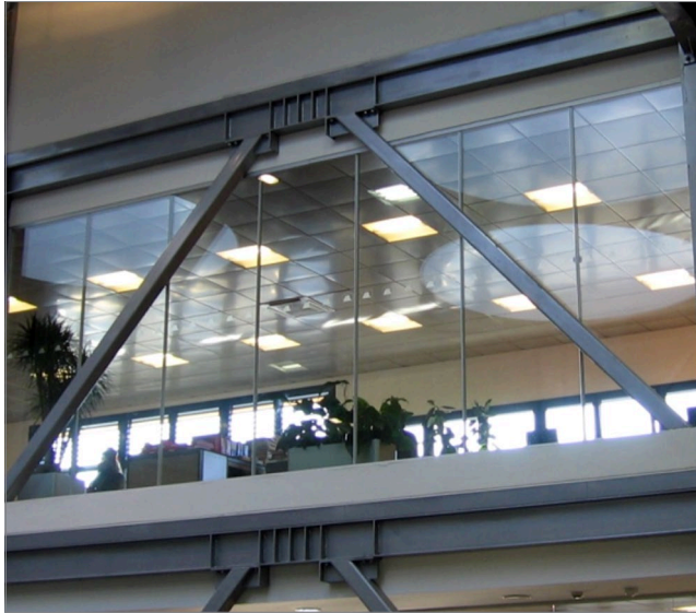
Figura 1.3. Esempio di edificio con controventi valorizzati architettonicamente anche sull'interno (Interpuls, Reggio Emilia)
